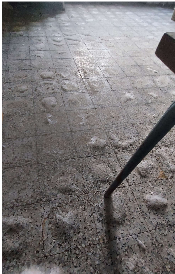
L'umidità di condensa e di risalita nel pavimento e le infiltrazioni delle acque meteoriche dalla copertura
