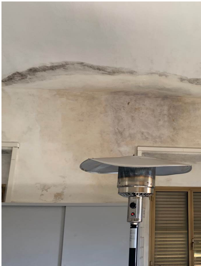
L'umidità di condensa e di risalita nel pavimento e le infiltrazioni delle acque meteoriche dalla copertura
