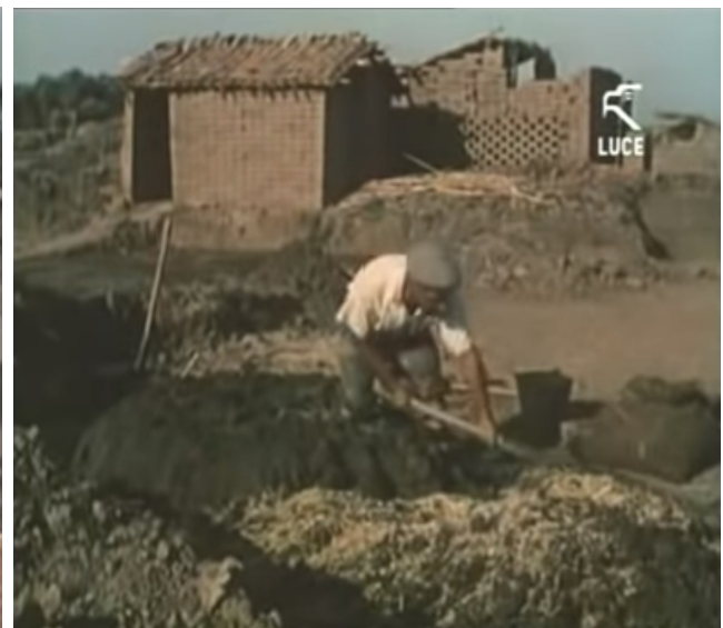
Immagini della fabbricazione delle tegole a Sili tratte dal documentario "NEI PAESI DELL'ARGILLA" di Fiorenzo Serra 1951
