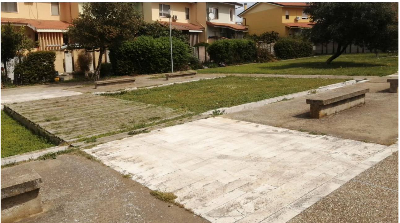
Fig. 15. PIAZZA VICO I PAOLO I-DETTAGLIO VASCA D'ACQUA IN DISUSO , LA QUALE RISULTA ATTUALMENTE RIEMPIITA CON TERRA
