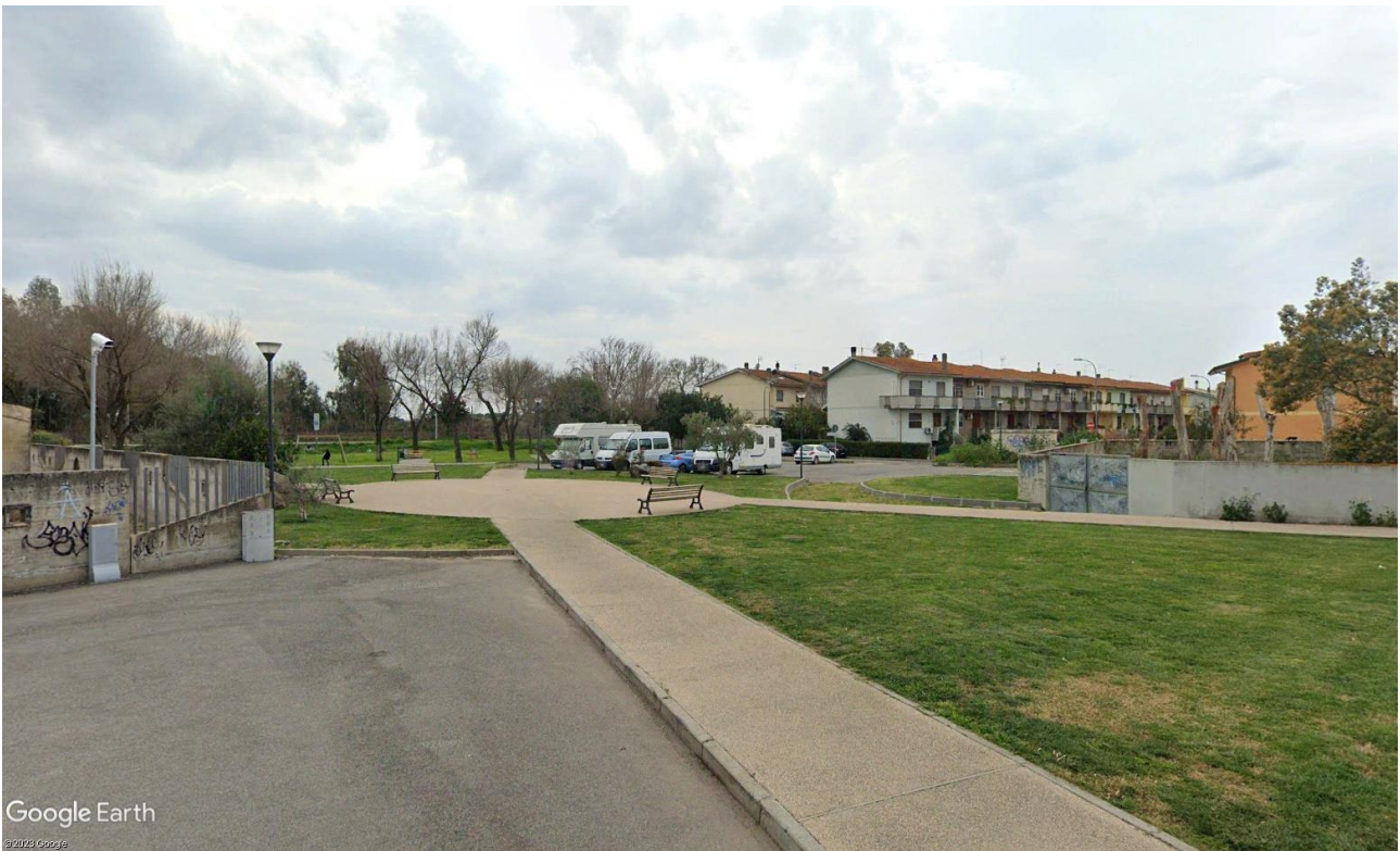
Fig. 17. GIARDINO COMUNALE DI SILÌ - VISTA DELLA PIAZZA ELLITTICA IN CALCESTRUZZO ARCHITETTONICO E DEI PERCORSI ATTUALMENTE POCO RAZIONALI E INCAPACI DI METTERE IN COMUNICAZIONE GLI EDIFICI AD USO PUBBLICO PRESENTI
