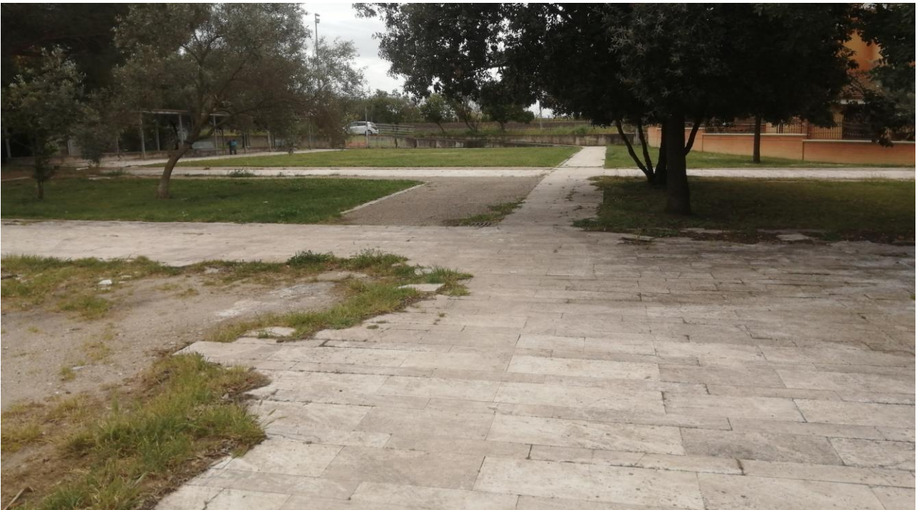
Fig. 9. PIAZZA VIA PAOLO I _DETTAGLIO DEL DEGRADO DELLA PAVIMENTAZIONE ESISTENTE IN BIANCONE DI OROSEI
