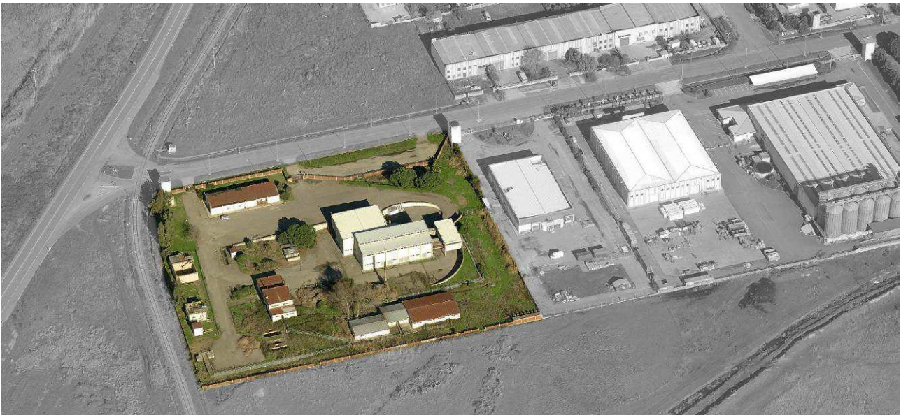
Stato di fatto ante primo intervento di recupero (2016) – dalla RELAZIONE TECNICA ILLUSTRATIVA DEL PROGETTO
