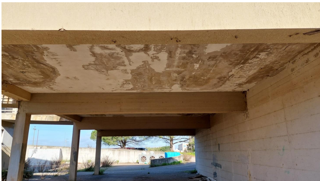
Foto stato di fatto – Passaggio sotto edificio Ex Macello (B')
