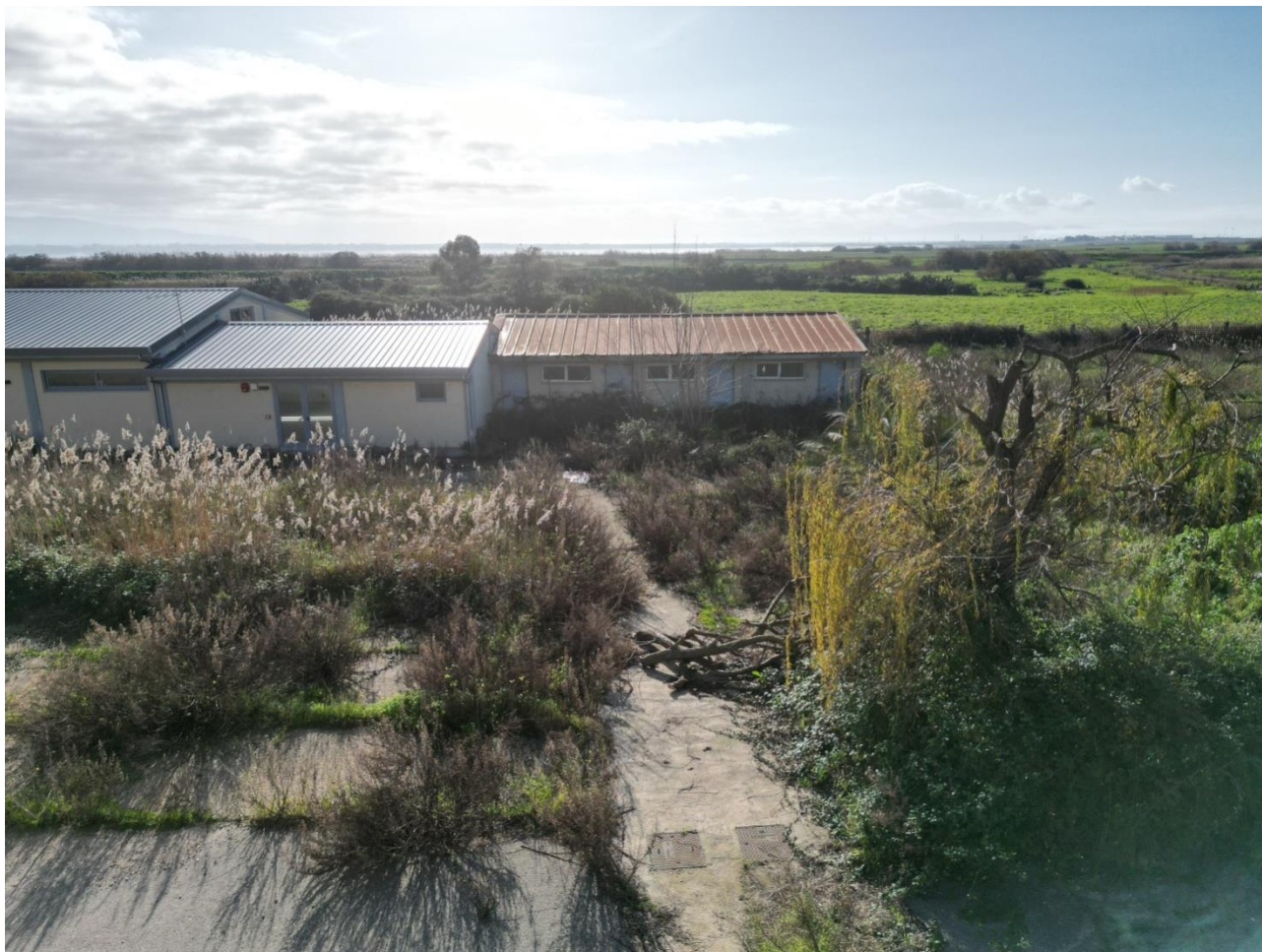
Foto stato di fatto – Presenza di folta vegetazione anche sulle aree pavimentate
