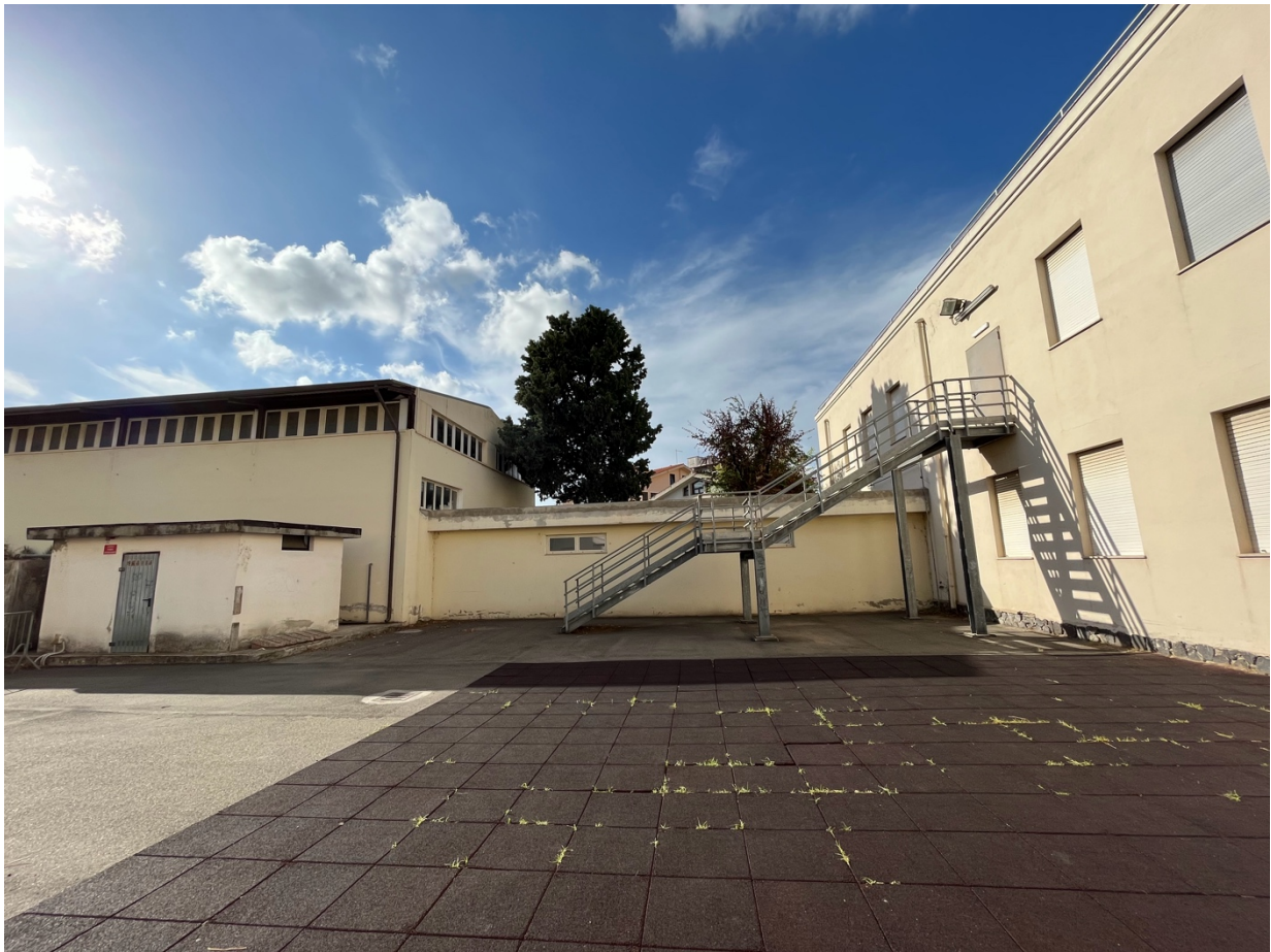
Foto – Tunnel palestra e Palestra
