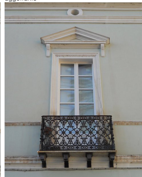
Piazza Martini, porta finestra con modanature a timpano e terrazzino aggettante
