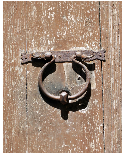
Via Crispi, dettaglio elemento in ferro
