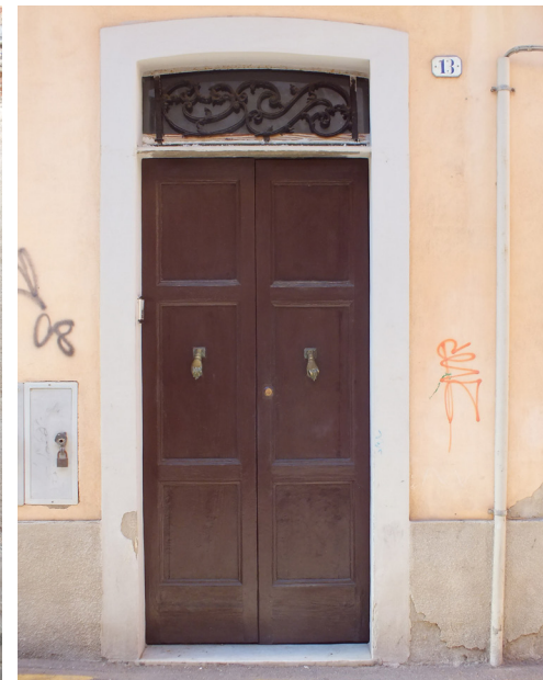
Porta con arco ribassato e sopraluce
