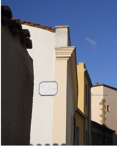
Gronda interna con muretto d'attico
