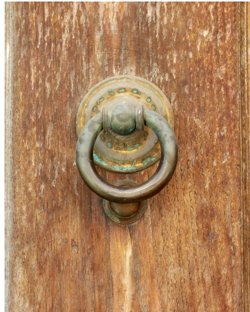
Via Crispi, dettaglio elemento metallico
