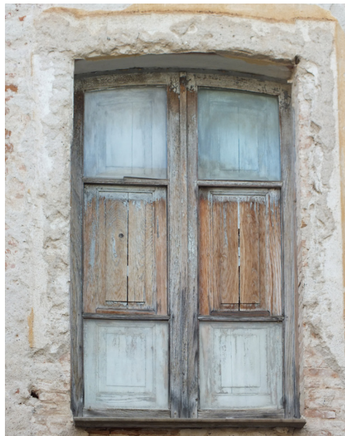
Via Parpaglia, finestra architravata con modanatura semplice
