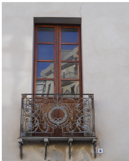
Via Duomo, porta finestra con terrazzino aggettante
