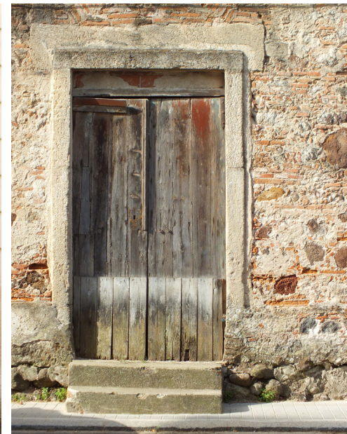
Via Angioy, porta architravata con stipiti in arenaria
