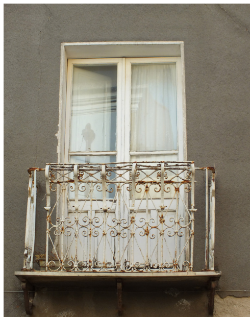
Via Crispi, porta finestra con terrazzino aggettante
