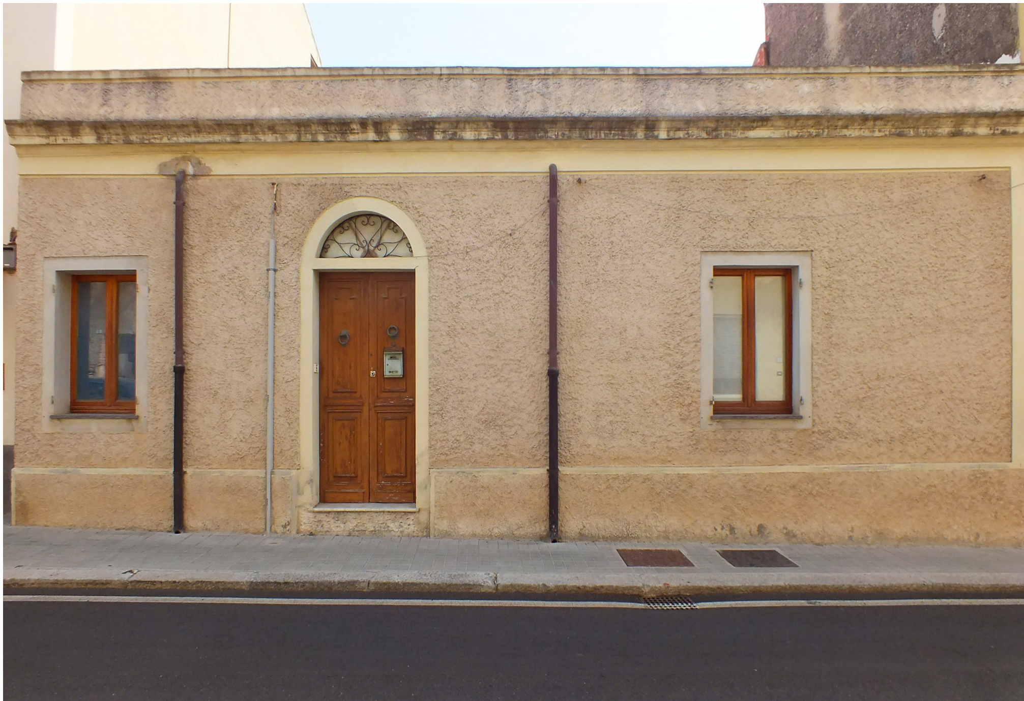
Via Angioi, esempio di tipologia edilizia di valore casa a corte media (Ccm)
