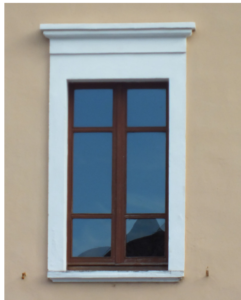
Via Duomo, finestra architravata con modanature
