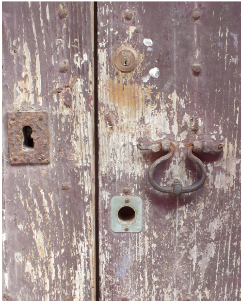
Via Lamarmora, dettaglio elementi in ferro
