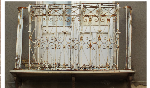
Dettagli di balconcini in metallo
