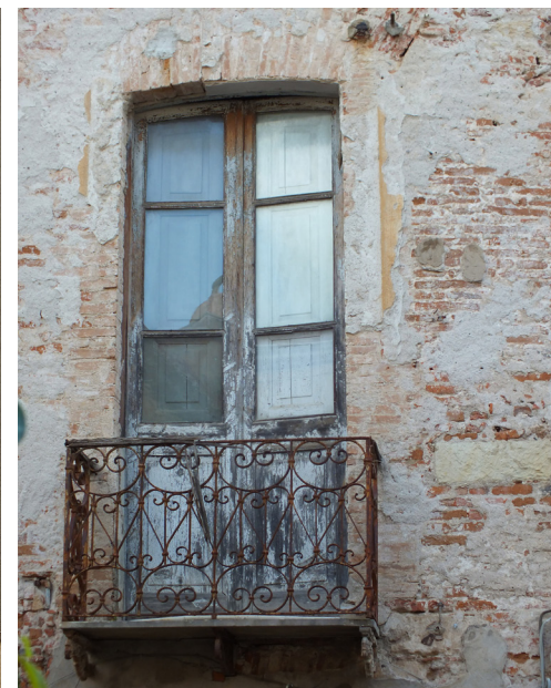
Via Parpaglia, porta finestra con terrazzino aggettante
