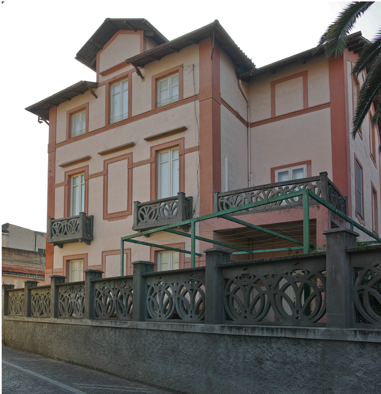
Nelle foto a sinistra e sotto, ER02 Palazzina Liberty via Santa Chiara, ex ISO12UE05, via Santa Chiara 8
